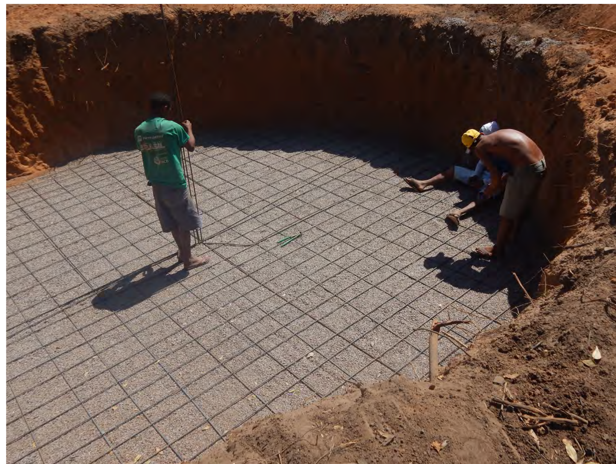
Cisterna Chapéu de Padre Cícero em construção na propriedade.
